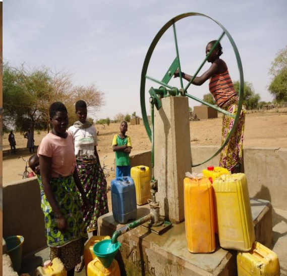
Agua no potable utilizada para beber. Pozo de Agua potable con bomba Volanta–BF
